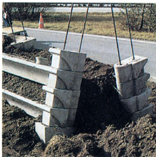
Parete Verde GW64 Inclinata; fasi di montaggio
